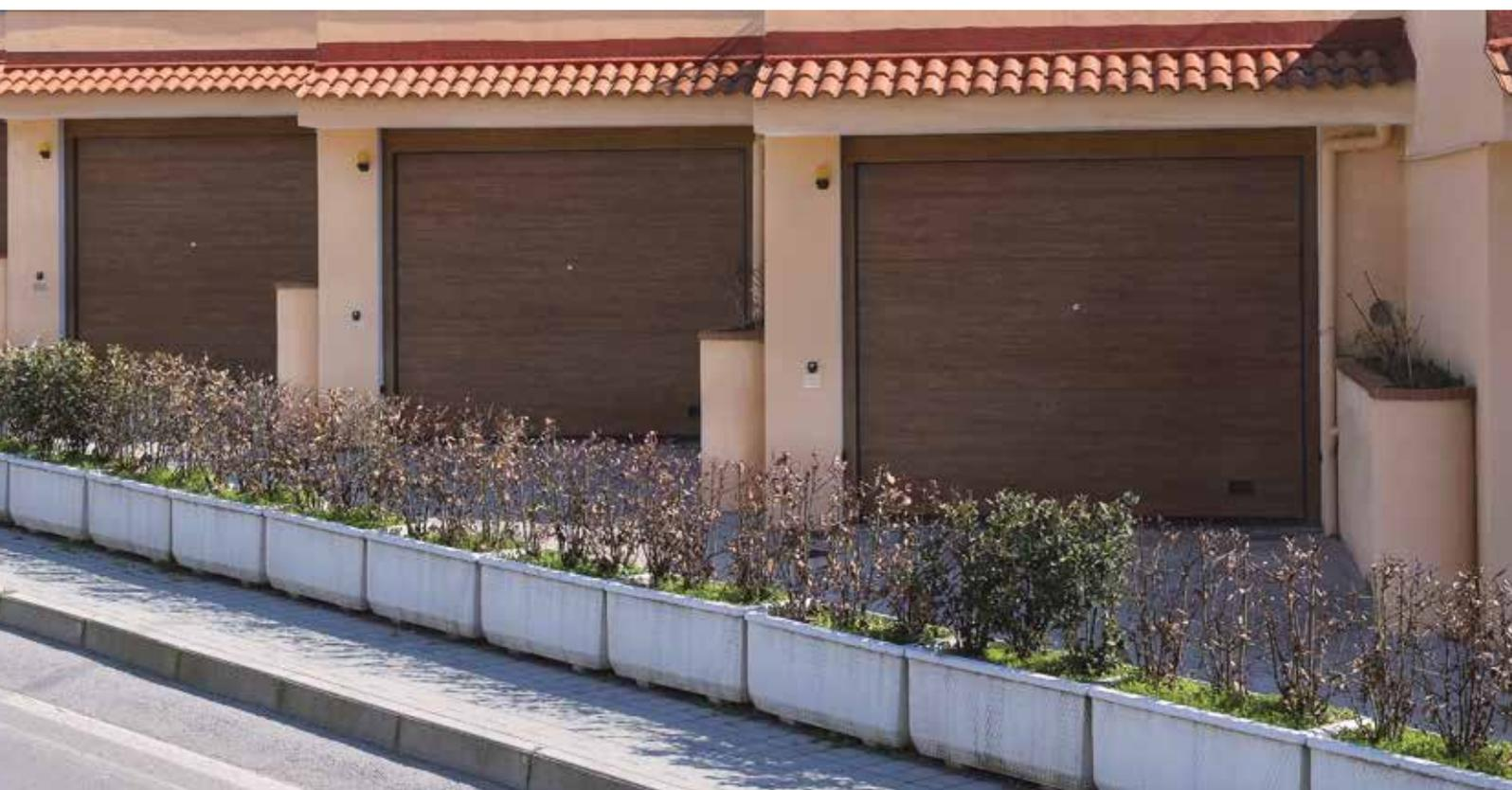
La parte mobile è composta da **pannelli coibentati** di altezza 500 mm, con lamiera preveniciata interna ed esterna spessore 0,5 mm, nelle **varie colorazioni e modelli**. Il coibente è in poliuretano espanso ad alta densità.
